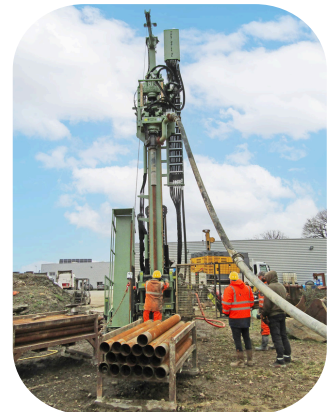
Forage d'un pieu géothermique
